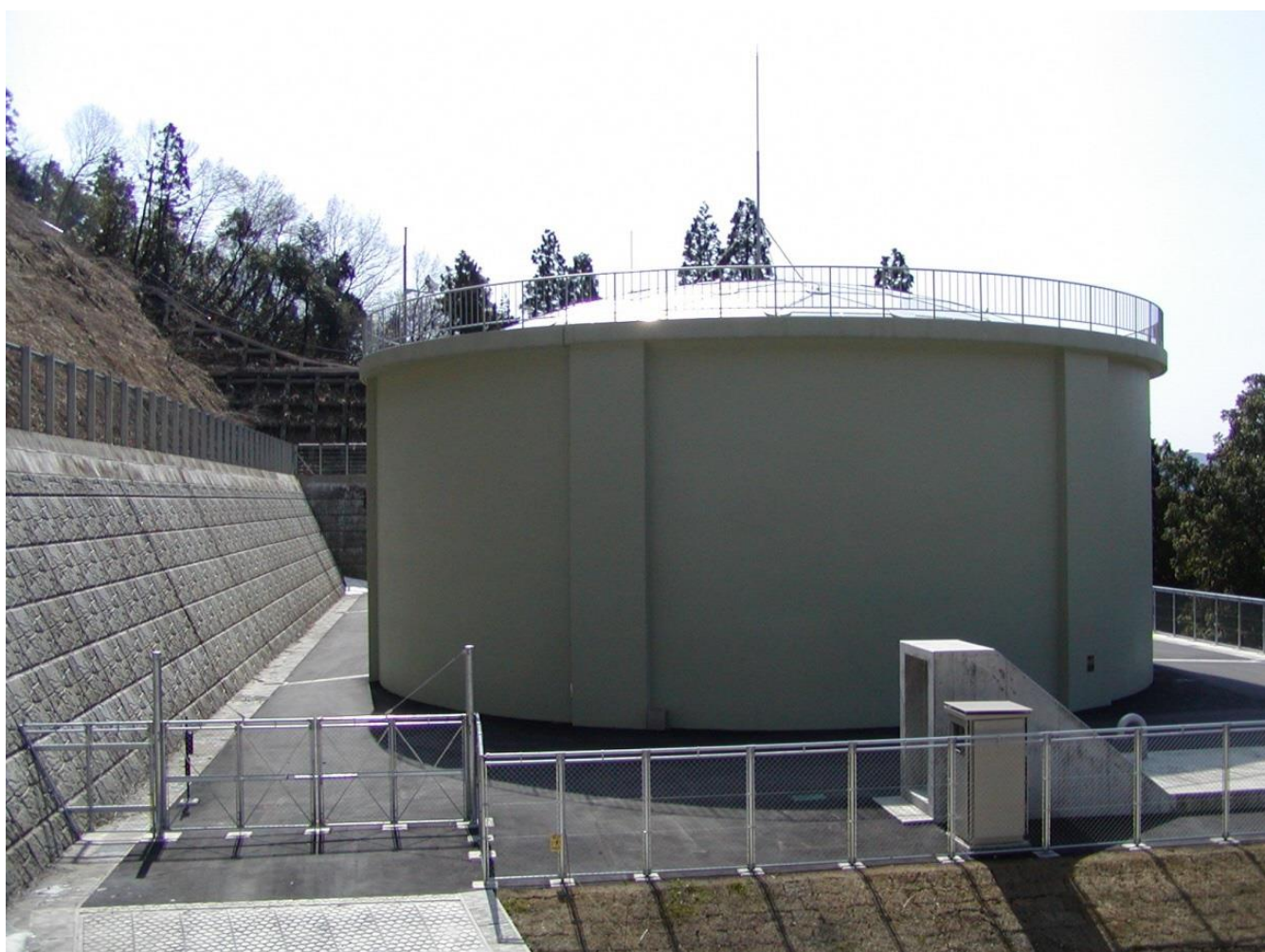
下新庄配水池
