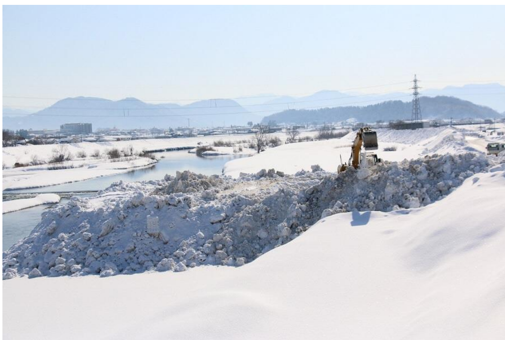
石田上町日野川左岸排雪場の様子
