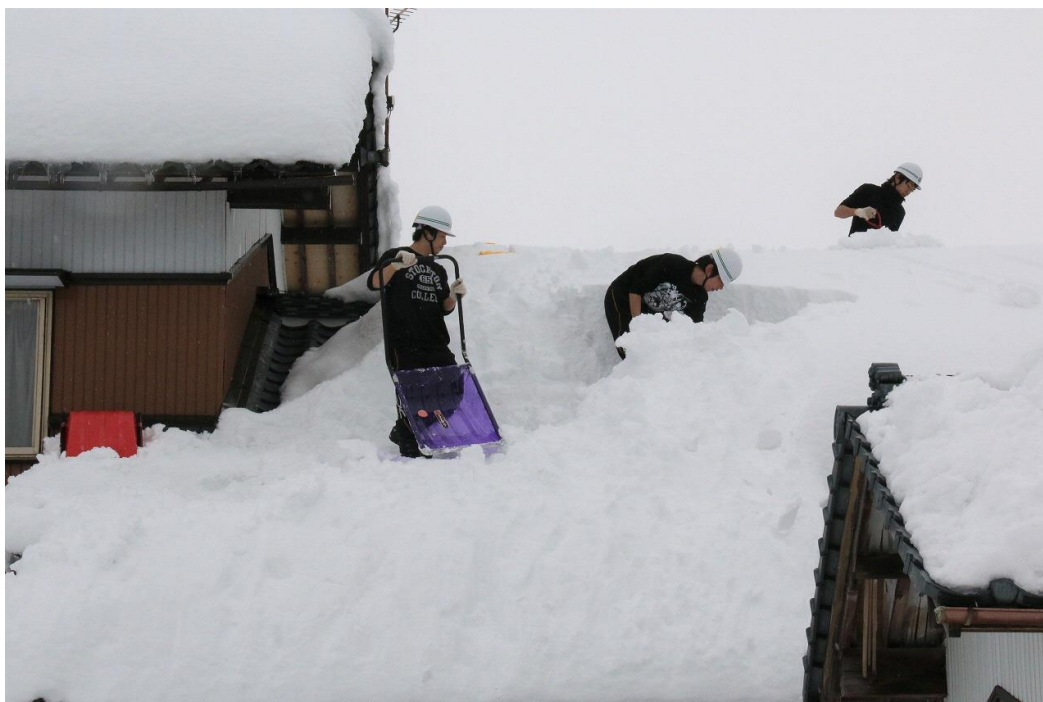
学生ボランティアによる屋根雪下ろし作業の様子
