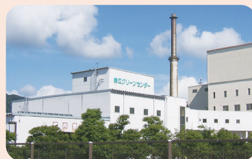
現在のごみ焼却施設
