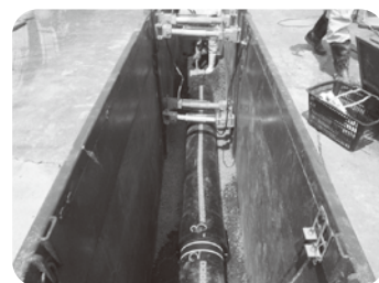
水道管の耐震化工事の様子
