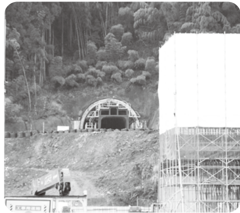
新幹線の工事風景
